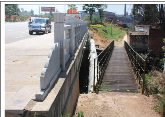
管线跨越小沙河
