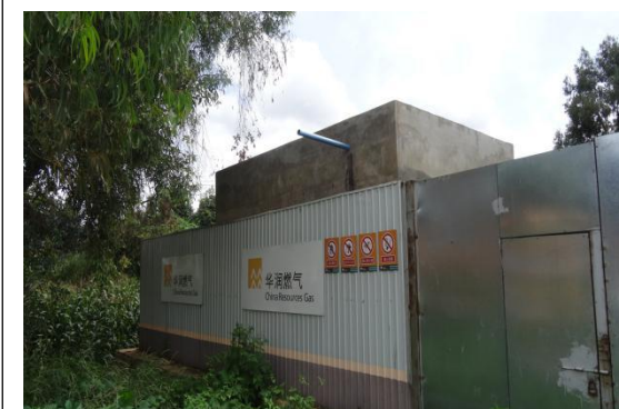
大渔支线调压站基础及彩钢板围墙
