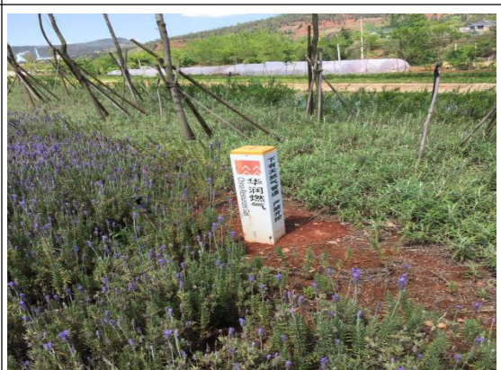
管线沿线警戒桩
