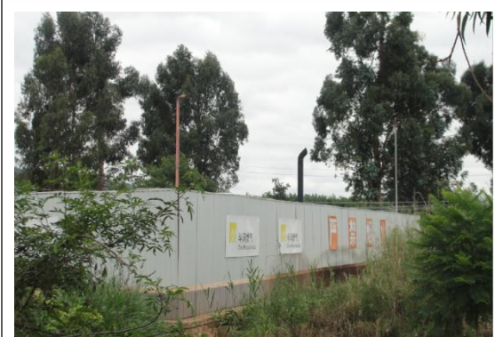
大渔支线调压站现状
