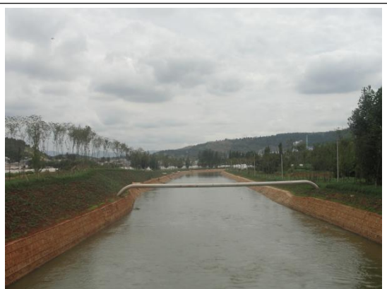
管道架空跨越螳螂川
