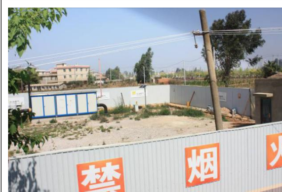
大渔支线调压站内部碎石铺填
